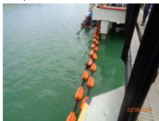
รูปที่ 2-5 ที่กั้นเพื่อป้องกันการแพร่กระจายน้ำมันในกรณีเกิดการรั่วไหลลงทะเล
