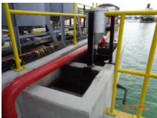
รูปที่ 2-3 บ่อ API และคั่นกันเพื่อดักน้ำมันและภาชนะรองรับน้ำมัน บนท่าเทียบเรือ
