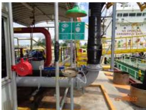
รูปที่ 2-14 จุดอาบน้ำและล้างตา กรณีฉุกเฉิน บนท่าเทียบเรือ
