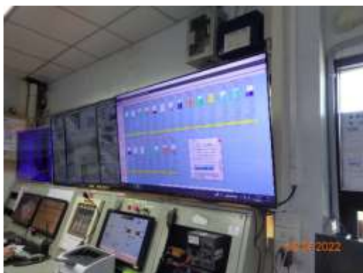
รูปที่ 2-1 ห้องควบคุมมาตรวัดระดับน้ำมันที่ถังเก็บน้ำมัน
