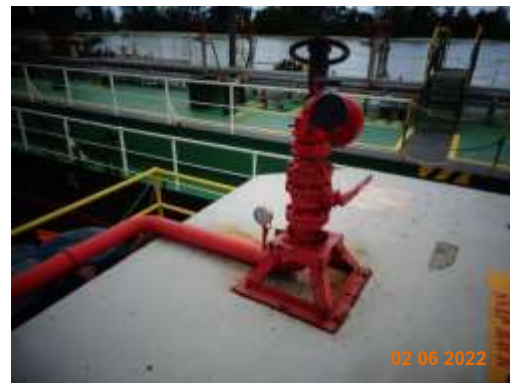
รูปที่ 2-19 อุปกรณ์และระบบดับเพลิงบนท่าเทียบเรือ
