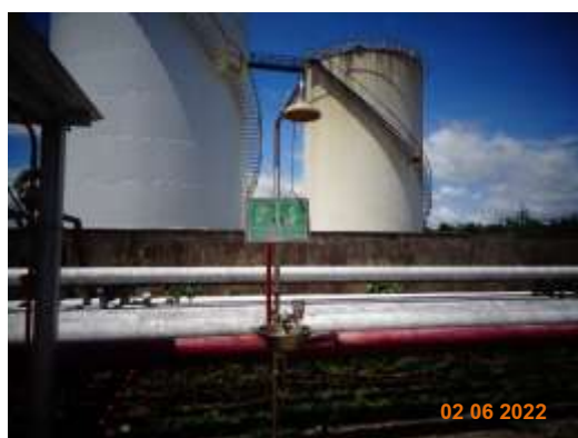
รูปที่ 2-28 ที่อาบน้ำและล้างตาในกรณีฉุกเฉิน
