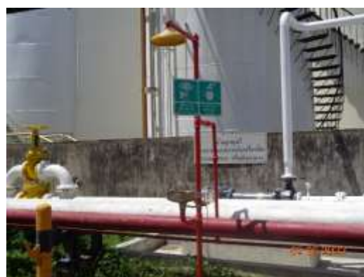
รูปที่ 2-28 ที่อาบน้ำและล้างตาในกรณีฉุกเฉิน
