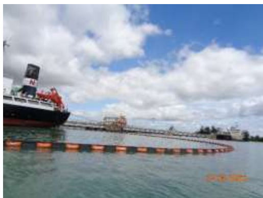
รูปที่ 2-5 (ต่อ) ที่กั้นเพื่อป้องกันการแพร่กระจายน้ำมันในกรณีเกิดการรั่วไหลลงทะเล
