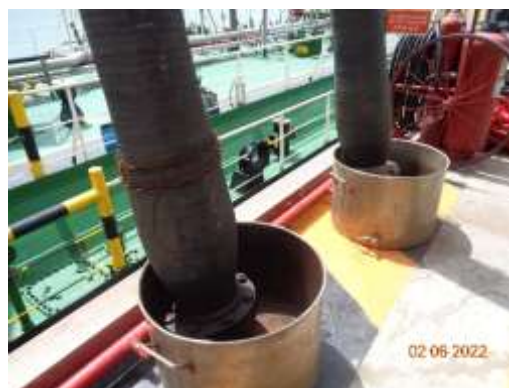
รูปที่ 2-3 บ่อ API และคั่นกันเพื่อดักน้ำมันและภาชนะรองรับน้ำมัน บนท่าเทียบเรือ
