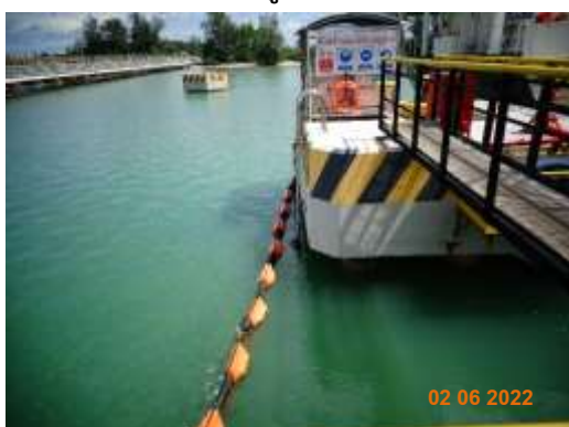
รูปที่ 2-5 ที่กั้นเพื่อป้องกันการแพร่กระจายน้ำมันในกรณีเกิดการรั่วไหลลงทะเล
