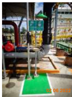
รูปที่ 2-14 จุดอาบน้ำและล้างตา กรณีฉุกเฉิน บนท่าเทียบเรือ
