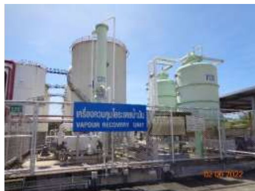
รูปที่ 2-26 เครื่องควบคุมไอระเหยน้ำมัน
